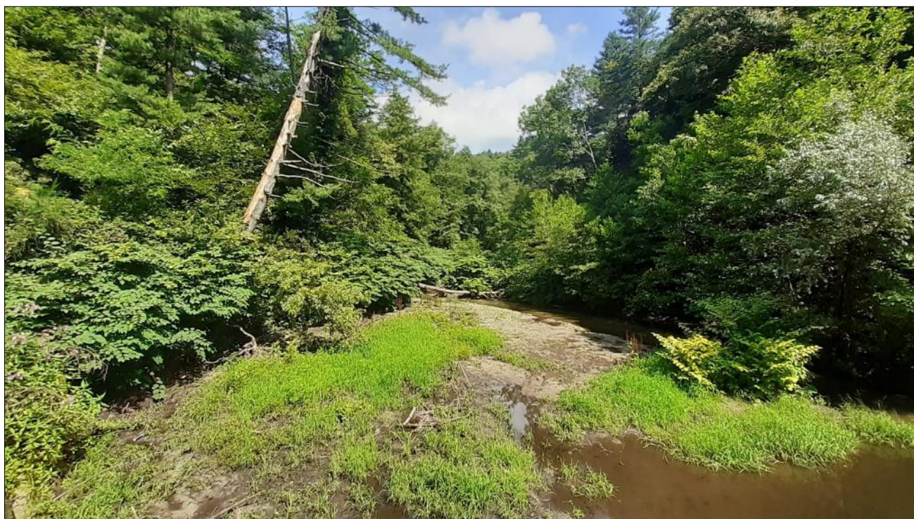
Area a monte della diga sul Rio Ballona, dopo la frana che a fine 2013 ha riempito l'invaso.
